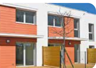
Résidence Clos de Soie- Bayonne Architecte Alexandre Courtois
